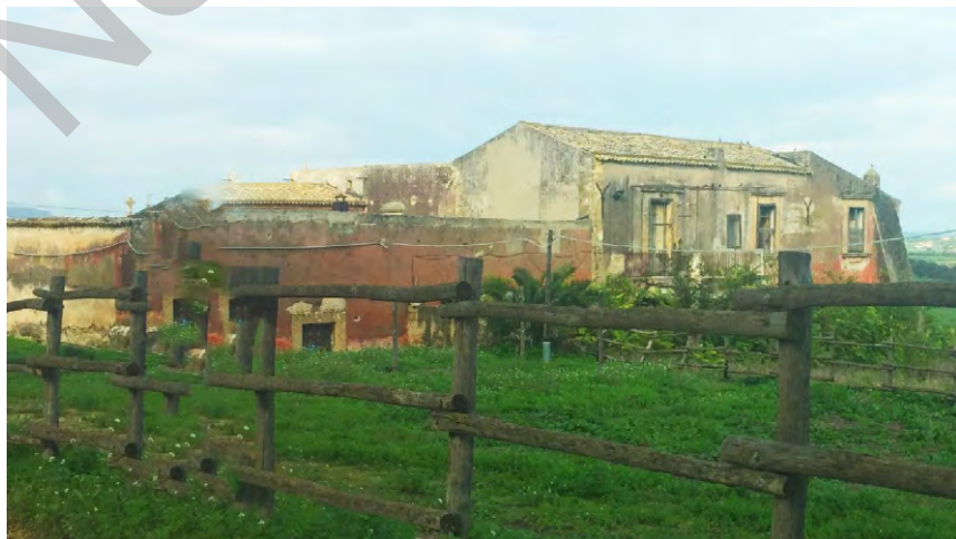
uno scocio delle strutture prima del restauro
